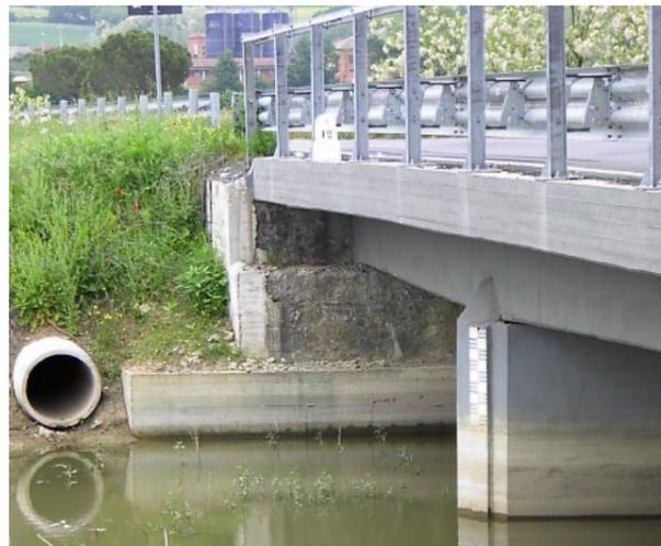
Figura 3 : vista spalla dx e trave di bordo dopo il consolidamento
