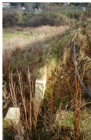
Figura 3 muro a retta spezzato dalla frana
