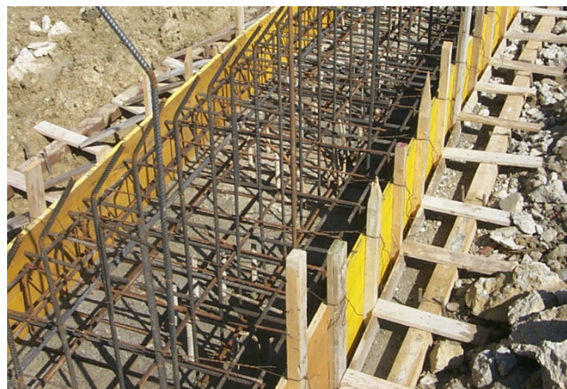
Figura 4 : trave collegamento testa dei pali
