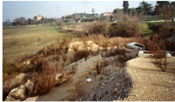
Figura 1 vista area interessata dalla frana
