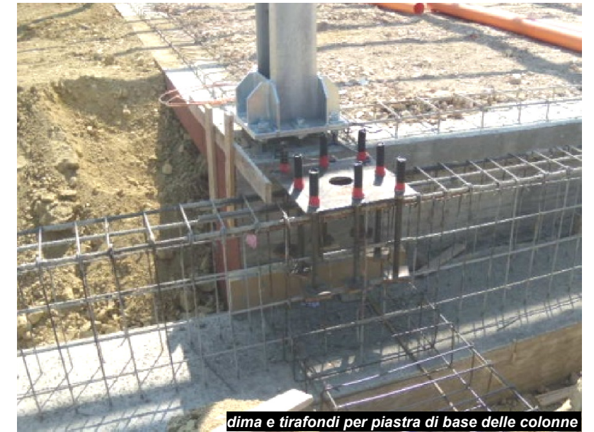
dima e tirafondi per piastra di base delle colonne
