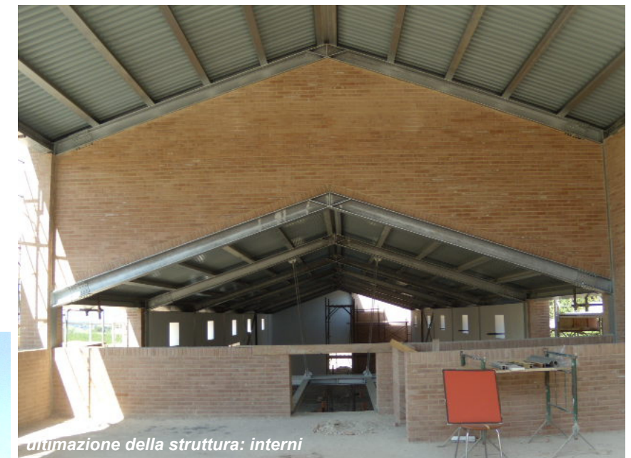
ultimazione della struttura: interni
