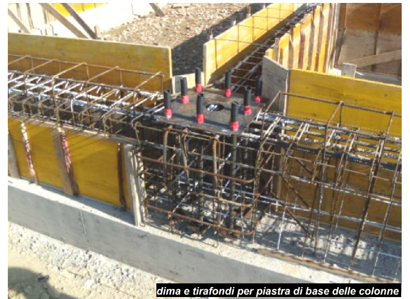
dima e tirafondi per piastra di base delle colonne
