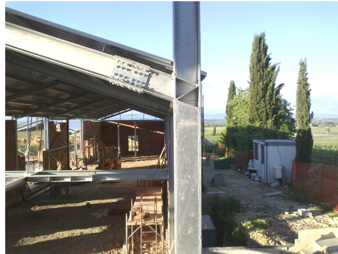
particolari esecutivi: nodo d'attacco travi – colonne e coprigiunto bullonato
