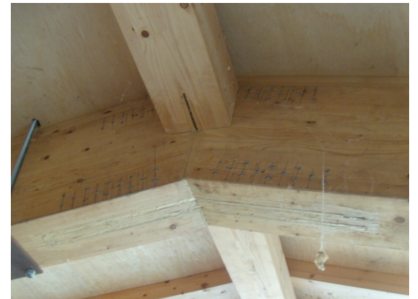
vista interna copertura: unione di testa tra travi in legno
