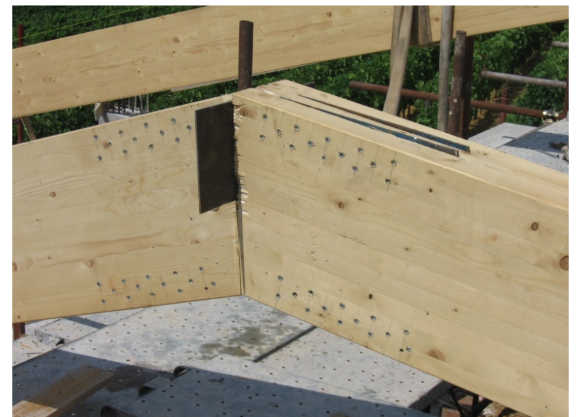
vista copertura: unione di testa tra travi in legno
