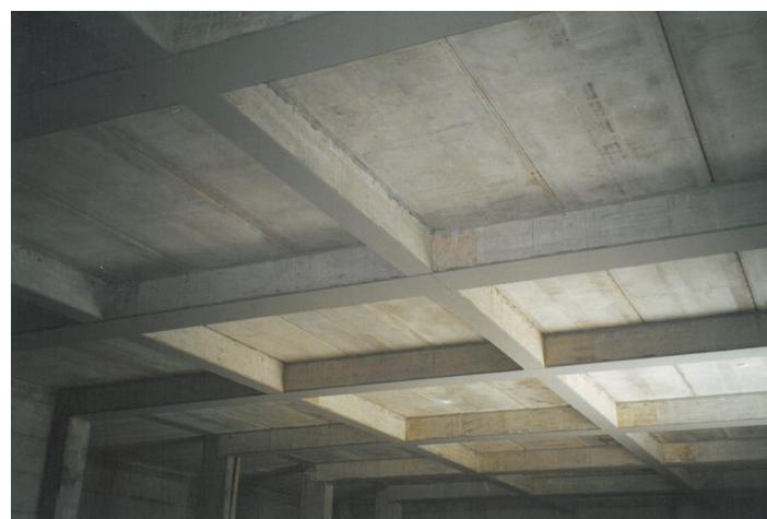
Vista intradosso solaio
