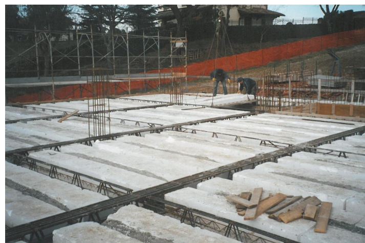
Montaggio solaio a lastra
