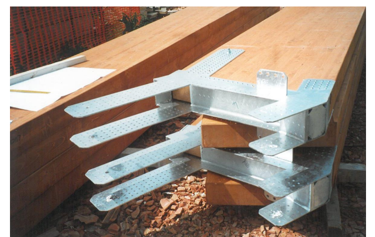
Giunzione capriata legno lamellare
