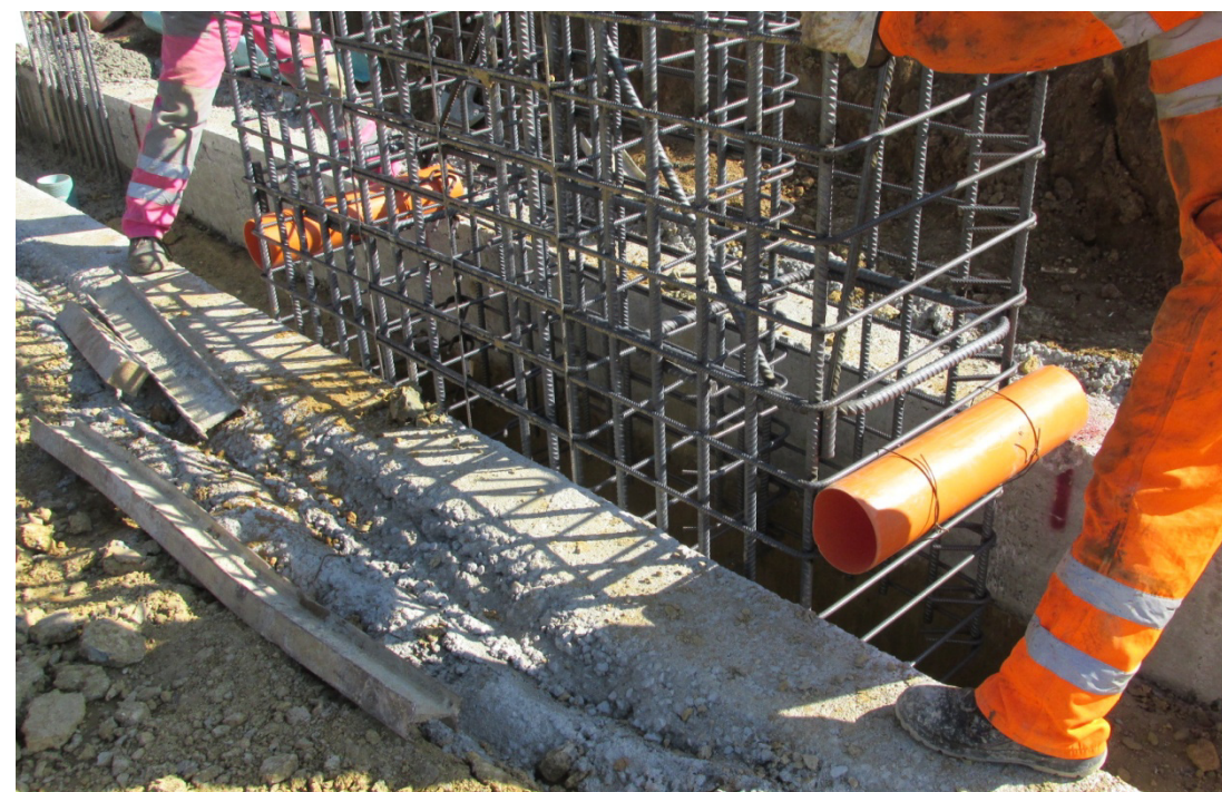
Posizionamento della gabbia di un diaframma
