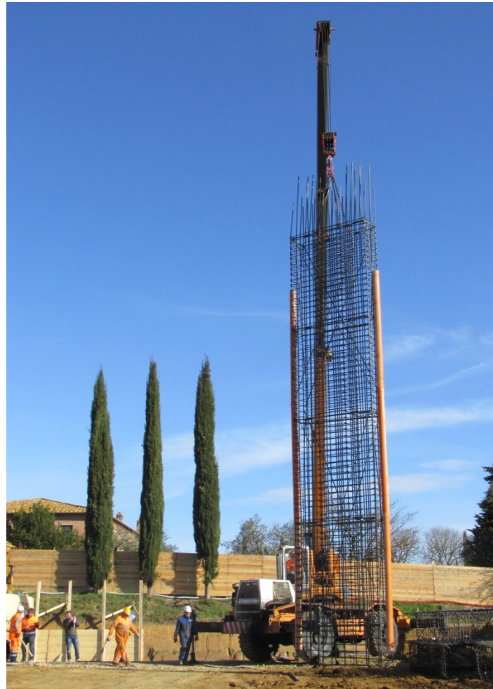
Posizionamento della gabbia di un diaframma
