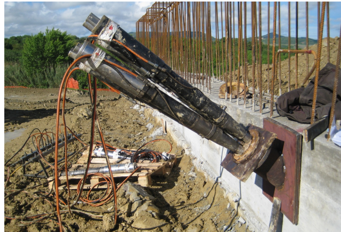
Tesatura di un tirante
