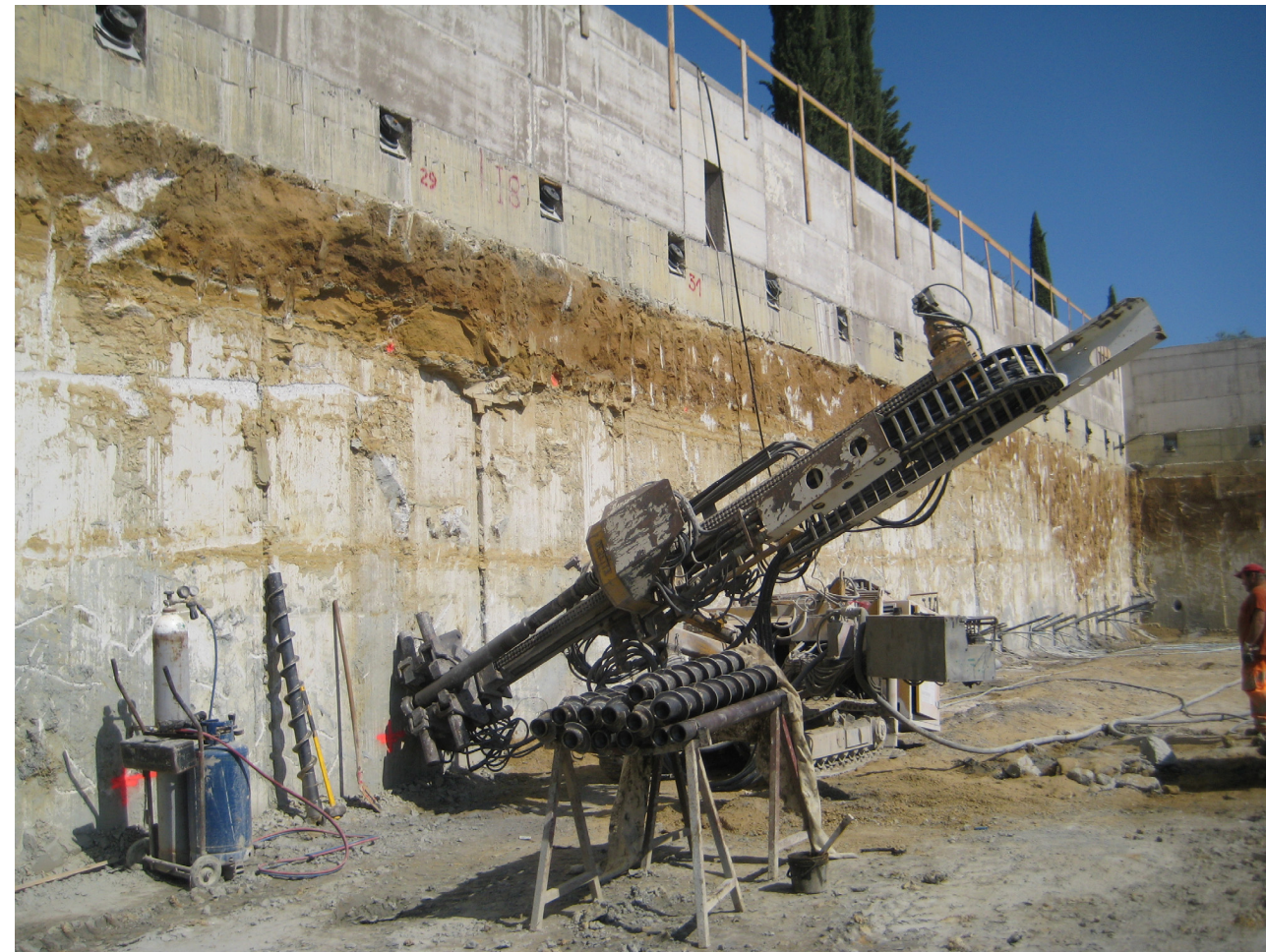
Esecuzione del secondo ordine di tiranti
