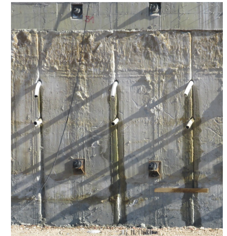
Particolare del fronte dei pannelli e dei drenaggi
