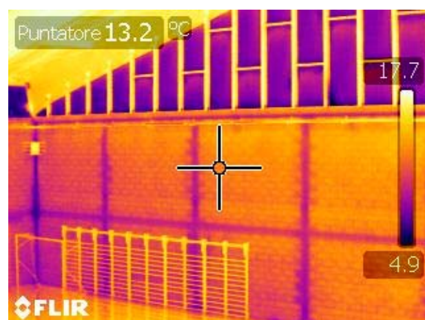
Indagine termografica sulle murature perimetrali ad integrazione dei saggi
