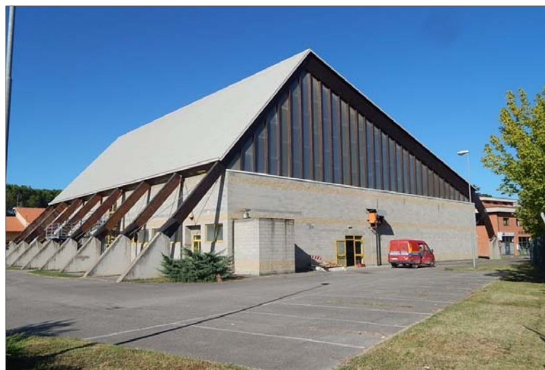
Scorcio: zona frontale e baraccatura laterale
