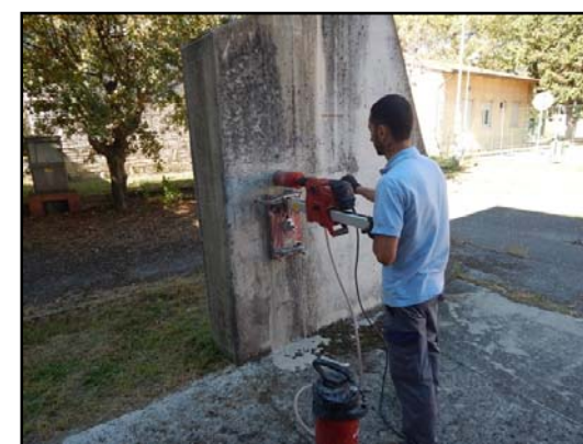
Esecuzione di un carotaggio
