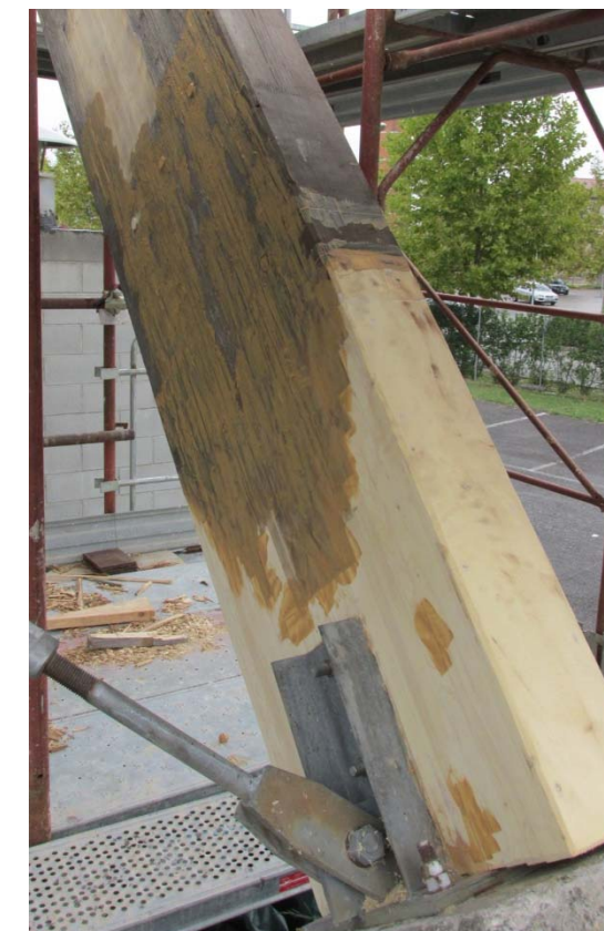
Lavoro di sostituzione delle lamelle terminato
